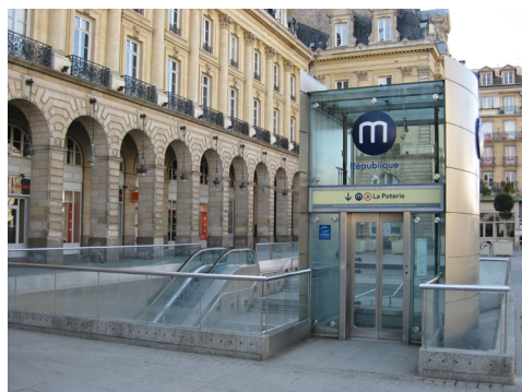
Station de métro dans la ville de Rennes
